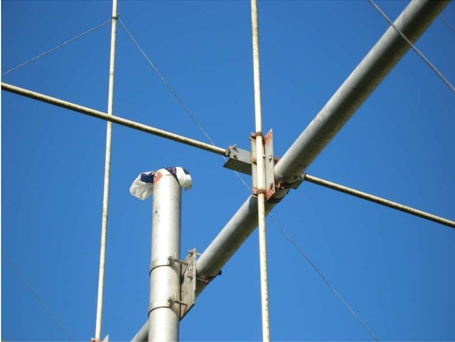
**Abbildung 2: Boomrohr und Befestigung Spreizer**
