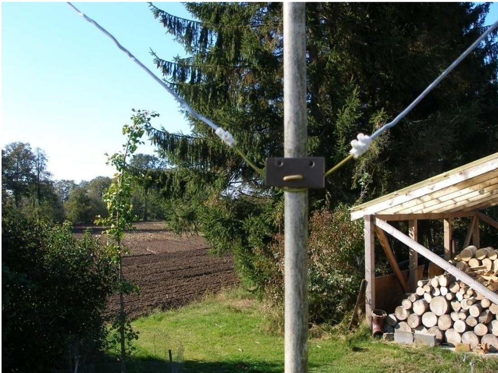
**Abbildung 13: Korrekte Ausführung Schleifenecke**
