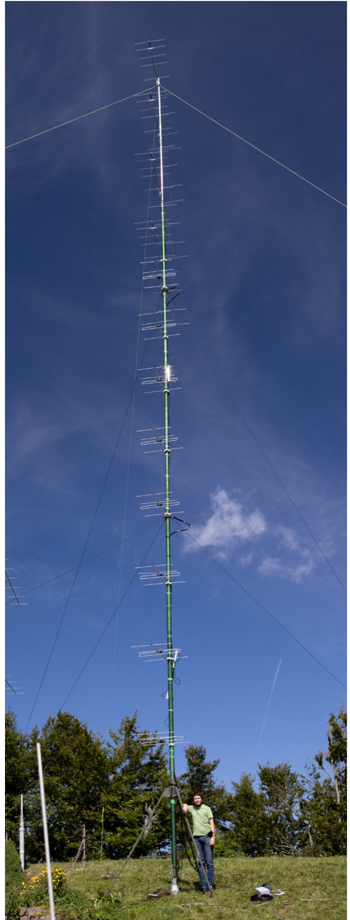
8x 4-Element nach Süden, darüber 4x 9-Element nach Norden. Rechts daneben DL8GM als Größenvergleich.
