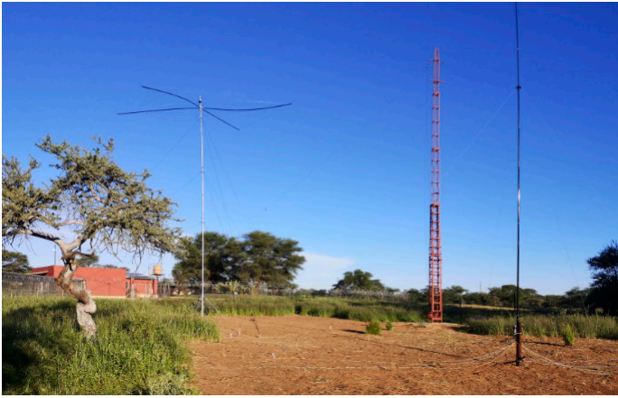
Die Antennenanlage von V51WH (v.l.n.r.): Spiderbeam, neuer Kippmast, Vertikal für 40m und 60m
