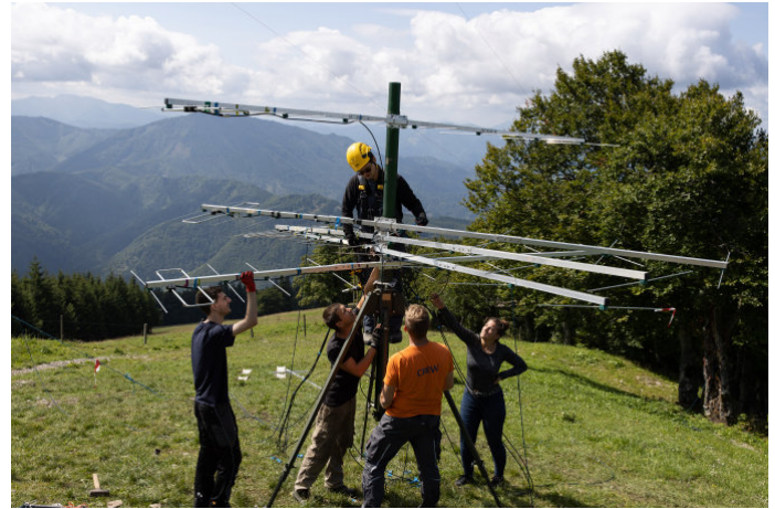
Die oberste Antenne hatte ein schlechtes SWR. Alles abbauen, überprüfen, reparieren und wieder aufbauen.
