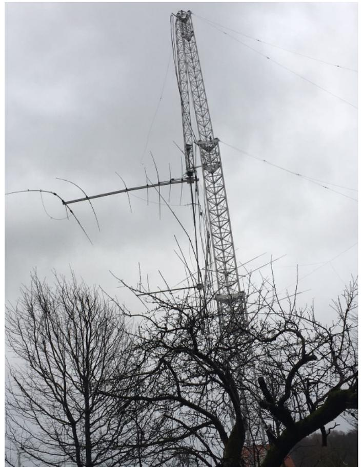
Abbildung 1 Der abgeknickte Mast
