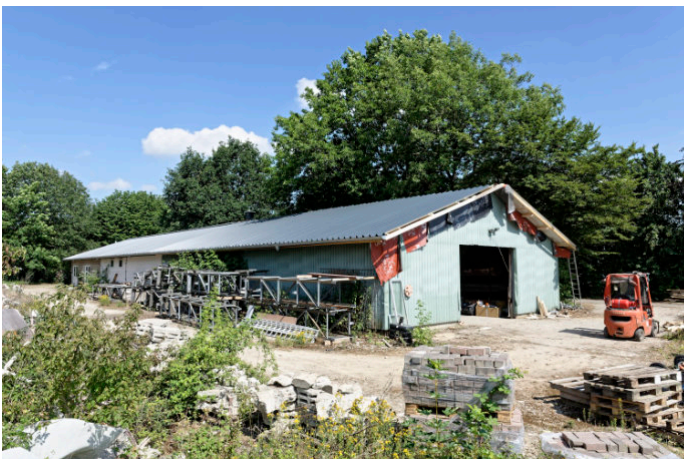
Bild 2 Das neue Stationsgebäude. Links: Funktechnik, Aufenthaltsraum. Rechts: Schlafräume, Werkstatt, Lager
