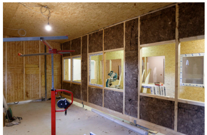
Bild 5 Drei Bandshacks im Rohbau (noch ohne Zwischenwände).
