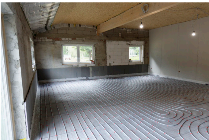
Bild 4 Der Aufenthaltsraum mit bereits ausgelegter Fußbodenheizung ist bereit für den Estrich.
