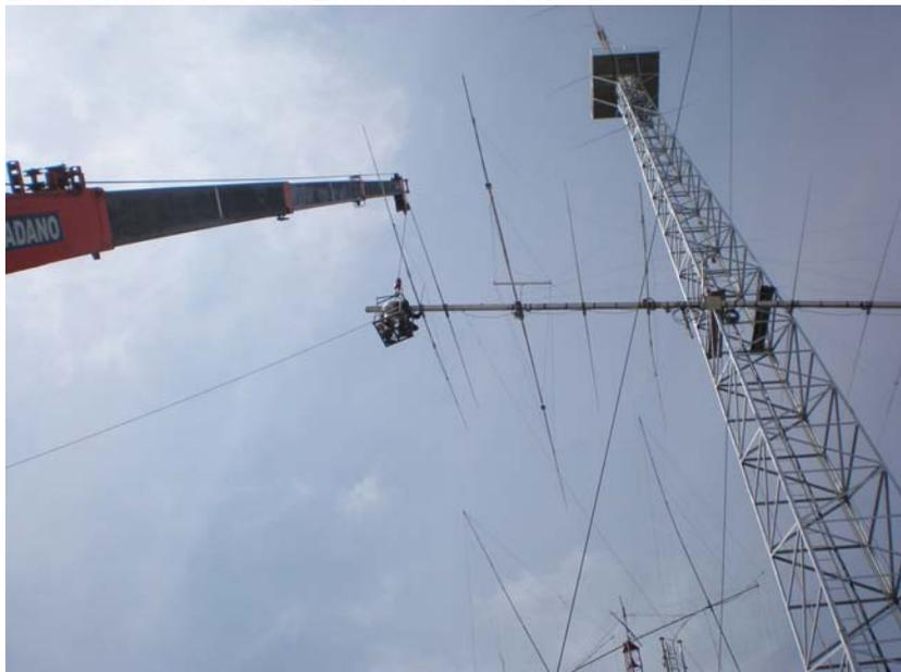
Bild 2: Montieren der Elemente
