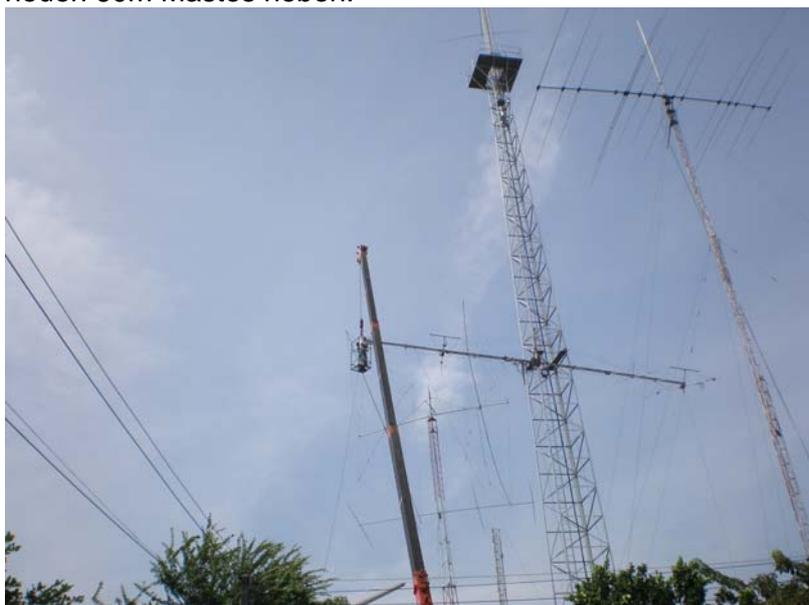
Bild 1: Montieren der Elemente an den OB804020 in 25m Höhe
