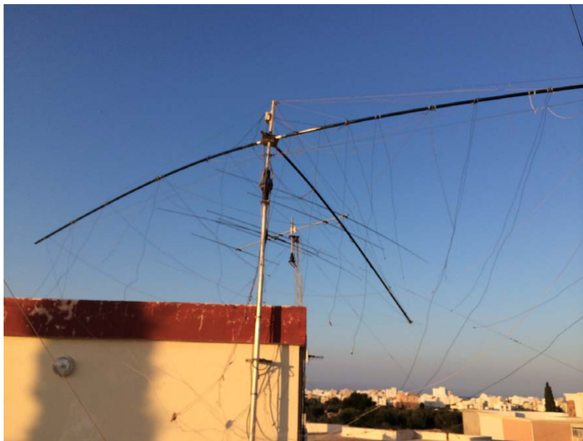
Antennenanlage von 3V8SS im August 2014, vor unserer Reparatur.
