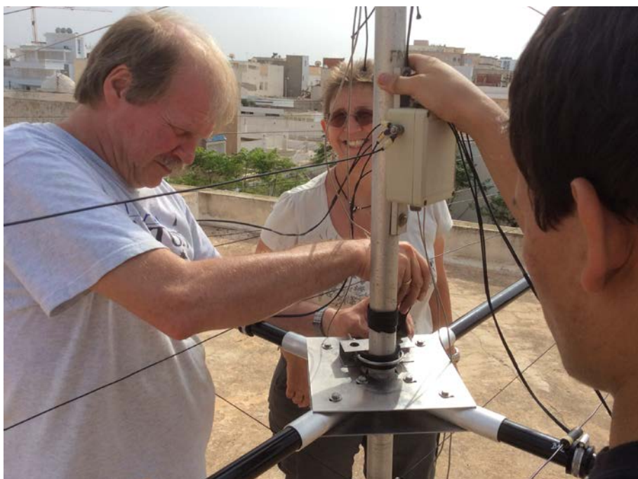
Unter der fachkundigen Leitung von Wolfgang, DK7MCX, werden die reparierten Elemente des Spiderbeams wieder zu einer Antennen zusammengesetzt.
