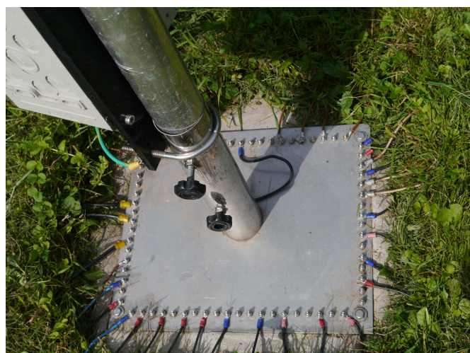
Bodenplatte mit 39 Radials
