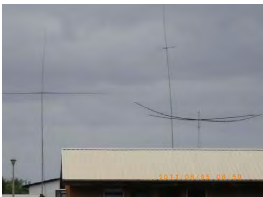
Antennenanlage: 1-Element-Multiband-Quad, Mehrband-Vertikal, Gleichzeitig Endpunkt der 80/160 m Drahtantenne, Spider-Beam.
